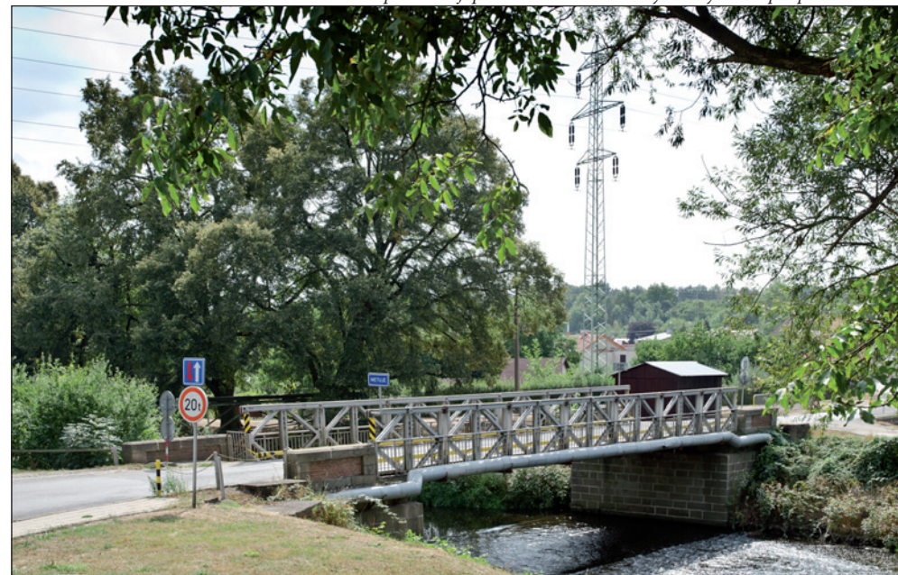
Most přes Metuji pod kostelem. Dříve to bylo i zdymadlo pro podhánění luk.
