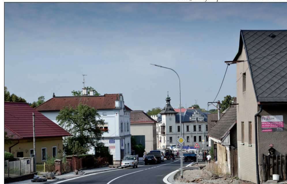
Ulice „1. máje“ - před dokončením rekonstrukce.
