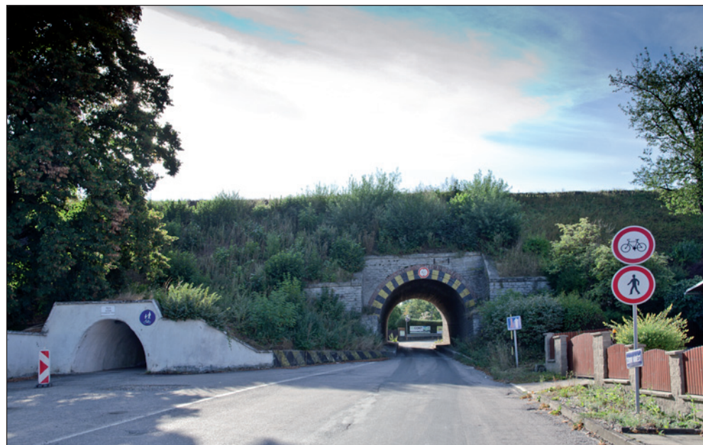
Tunel pod železnici těsně před rekonstrukcí. Vlevo průchod pro pěší.
