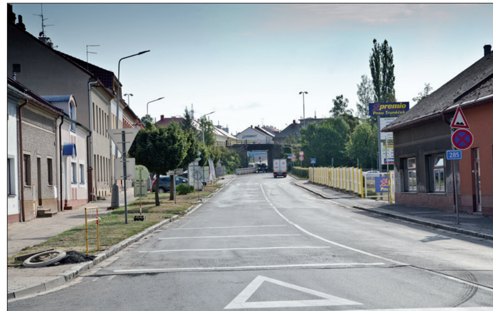
Havlíčková ulice s uzavřeným podjezdem před rekonstrukcí.
