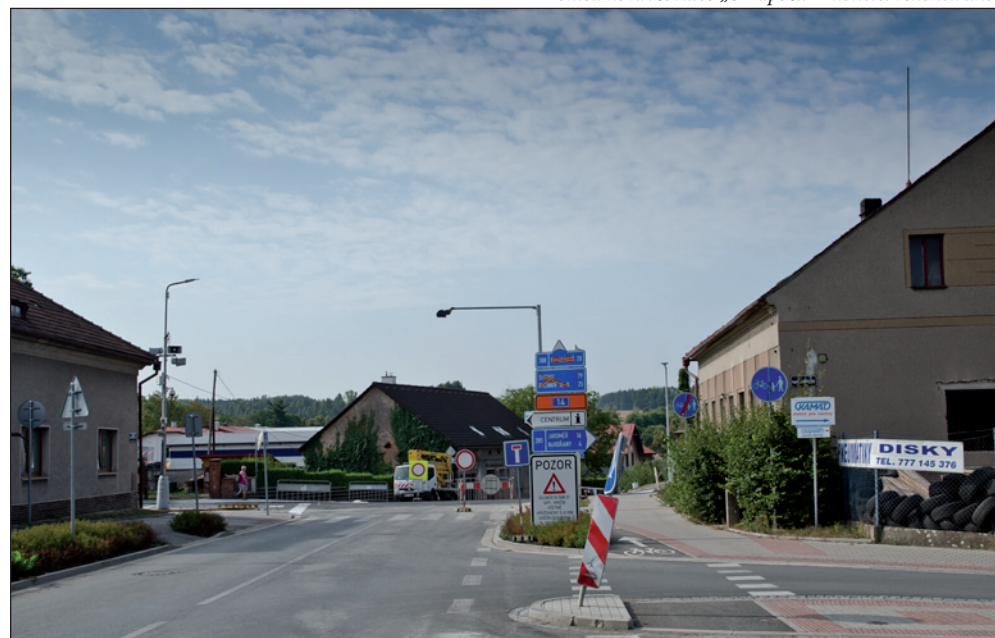
Pohled ke křižovatce „U Papežů“ - končící rekonstrukce.
