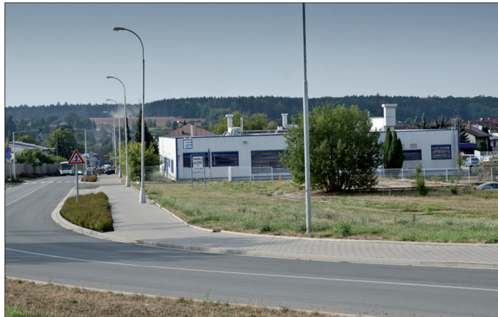
Náchodská ulice po nedávné rekonstrukci s přilehlými firmami.
