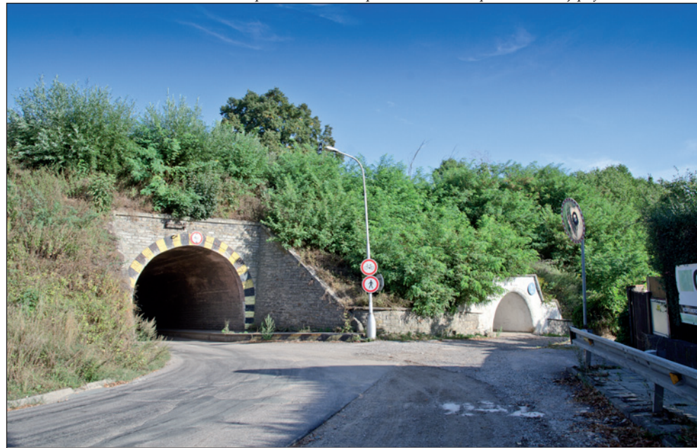
Tunel pod železnici těsně před rekonstrukcí - pohled ze strany příjezdu od Dobrušky.
