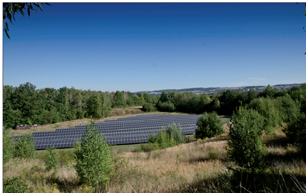
Sluneční elektrárna v prostoru bývalé cihelny.
