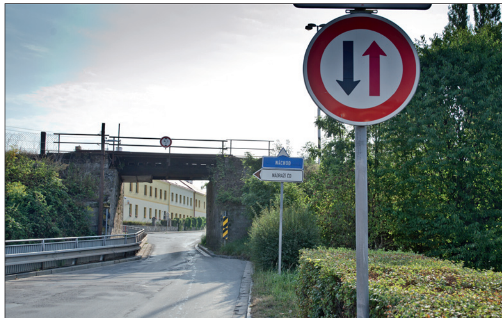
Železniční podjezd u nádraží - těsně před rekonstrukcí.
