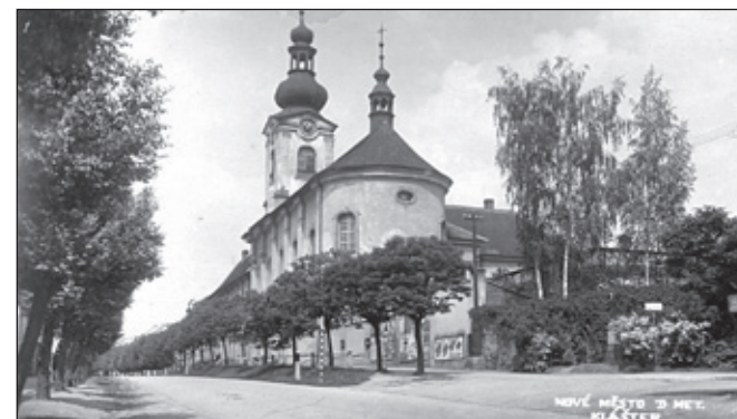
Stavba nové vozovky. Klášter - interiér lékárny 1920. Klášter Milosrdných bratří 1931.
